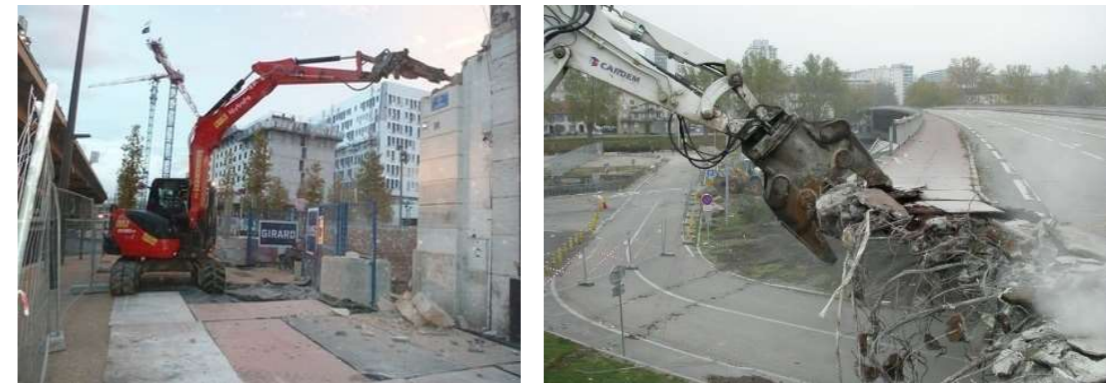
Exemples de brise-roches hydrauliques et pinces croqueuses (Sixense Environment)
