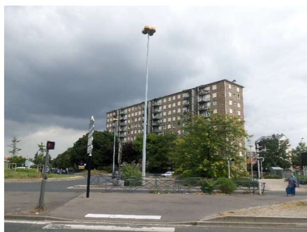
13 : Station de tramway, vue vers le nord-est (vue vers la Cité Gaston Roulaud) (MEDIATERRE Conseil, 2018)
