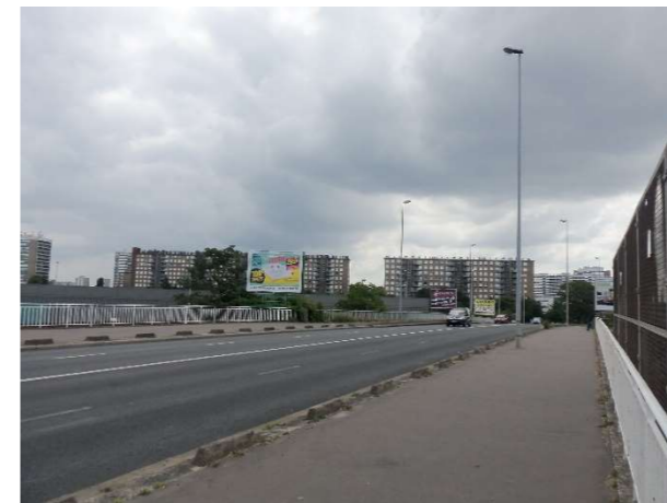
03 : Pont-route de la rue de Stalingrad-RN186 (vue vers l'est) (Cité Gaston Roulaud depuis le pont, en arrière-plan – haut des barres d'immeubles) (MEDIATERRE Conseil, 2018)
