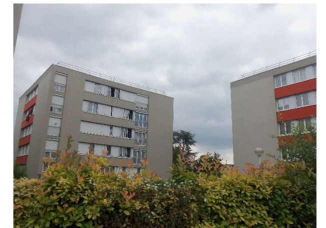
08 : Immeubles à Bobigny, le long de la rue de la Purée (absence actuelle de cohérence architecturale avec la Cité Gaston Roulaud, non visible par ailleurs depuis ce point) (MEDIATERRE Conseil, 2018)
