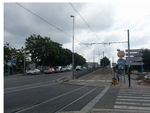
Carrefour entre la rue de Stalingrad et la rue Romain Rolland – vue vers l'est (covisibilité depuis l'hôpital Avicenne) (MEDIATERRE Conseil, 2018)
