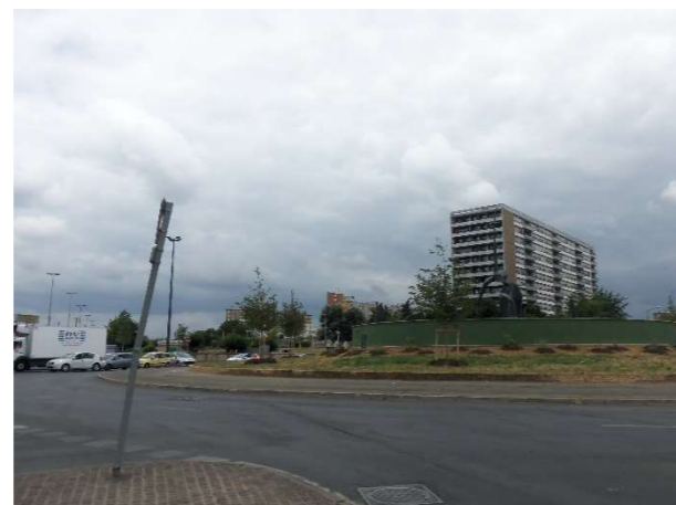
10 : Rond-point RD115-RN186, vue vers le nord-ouest (absence de visibilité sur la Cité Gaston Roulaud) (MEDIATERRE Conseil, 2018)
