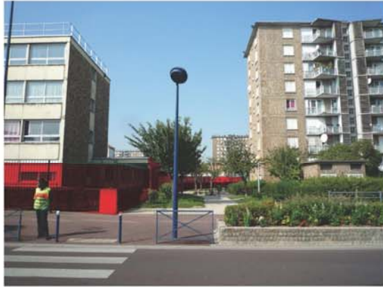
Absence de percée visuelle vers le parc depuis la rue Salengro
