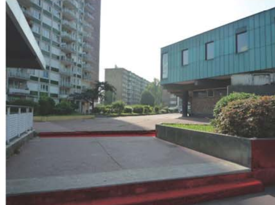
Accès à la dalle contraint
