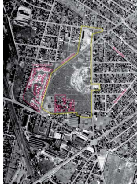
1955 Démolition hangar industriel – Maisons – Rues Voltaire – Montesquieu – Rue Fernand Pena
